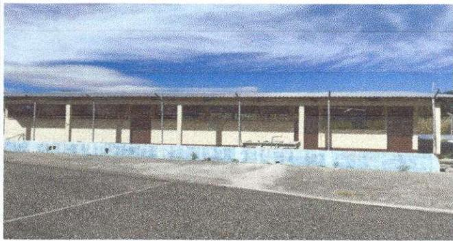
Foto1: Susitución de lamina por lamina troquelada aluzinc calibre 26
