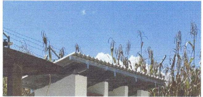
Foto 2: Sustitución de estructura de soporte de madera por metal (3x2 pulgadas)
